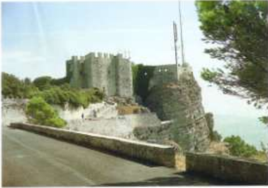
Edrisi (1100-1166) parlò della «fortezza che non si custodisce» che sorgeva nel sito più alto del monte, là dove nell'antichità fu il santuario della Dea. I Re normanni la ricostruirono ed il viaggiatore Ibn Gubayr (1145-1217) la considerò inespugnabile, come in effetti essa fu per lungo trascorrere di secoli.
