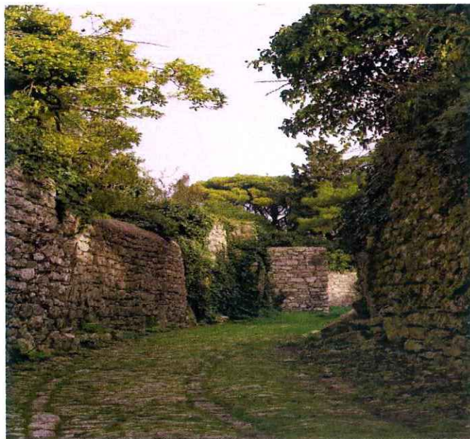
Figura 4. Caratteristica via ericina. Visibile le mura ciclopiche e la pavimentazione in basolato a catena
