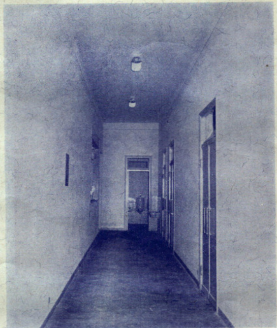
Uno dei corridoi della palazzina che disimpegna gli uffici dagli spogliatoi, dai servizi e dall'infermeria
