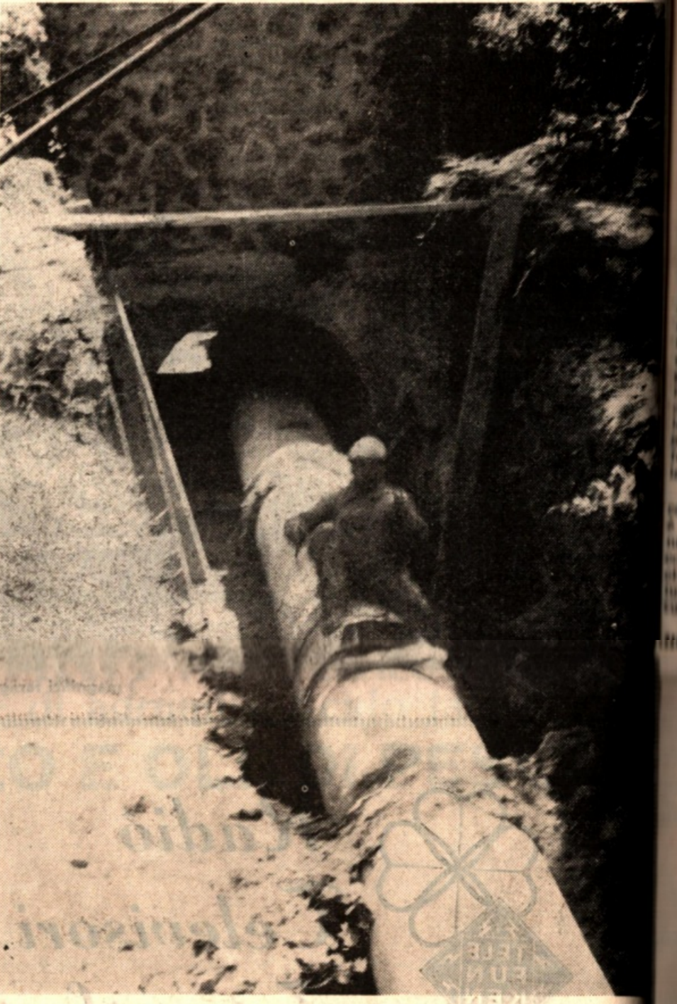
Una condotta posta in opera dell'acquedotto di Alcantara
