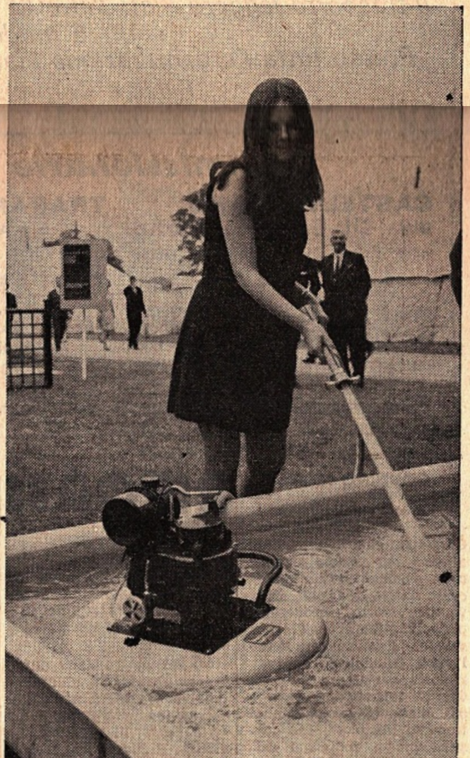
Questa comodissima pompa galleggiante è stata esposta al Royal Show che si tiene annualmente in Gran Bretagna. La pompa facilmente trasportabile può funzionare ovunque vi sia una sorgente di acqua ed è ideale per piccole irrigazioni, riempimento di serbatoi, ecc.
