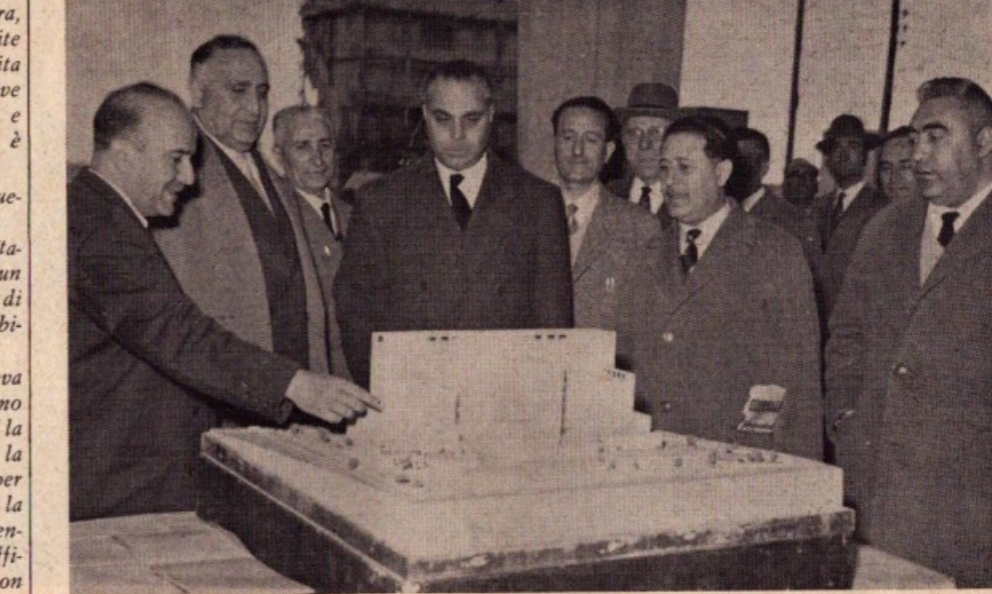
TRAPANI, 1956: Il ministro Mattarella visita i lavori per la costruzione del nuovo Ospedale «Sant'Antonio»; l'avv. Bartolo Rallo gli illustra il plastico
