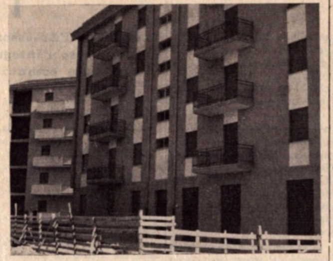
Complesso di n. 8 lotti per un totale di 66 alloggi realizzati al Rione Palme
