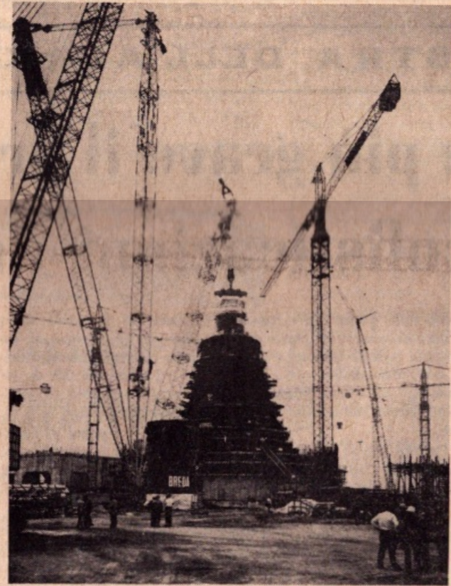
Breda Termomeccanica: Montaggio di parti interne entro la parte inferiore del contenitore a pressione per la centrale elettro-nucleare E.N.E.L. di Caorso (Piacenza)
