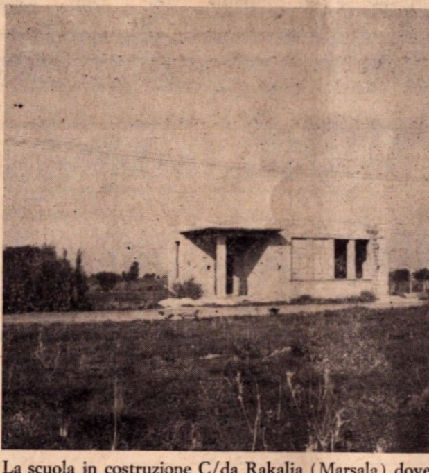
La scuola in costruzione C/da Rakalia (Marsala) dove fu trovata Antonella Valenti
