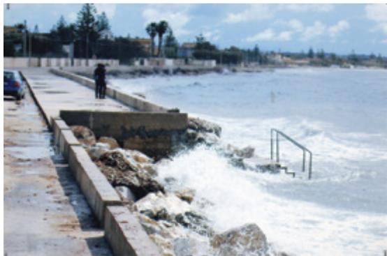
L'avanzamento del cemento e dell'asfalto sempre più a mare potrebbe essere la causa preponderante dell'erosione della spiaggia di Tonnarella. Notasi il passamano in acciaio immesso subito dopo il ripristino del tratto stradale crollato. Nell'inverno dello stesso anno è stato spazzato via dalle onde che, anziché essere naturalmente attutite ed assorbite dalla sabbia della spiaggia, mantengono tutta la potenza nello scontro con lo zoccolo duro del cemento e dell'asfalto
