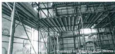
Ponteggi all'interno della chiesa
