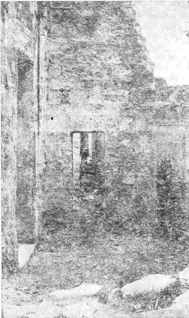
Degradanti e disgustosi particolari del Centro Storico
