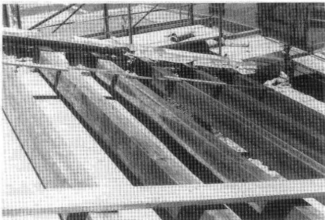
Le travi nuove collocate per la copertura del tetto del transetto
