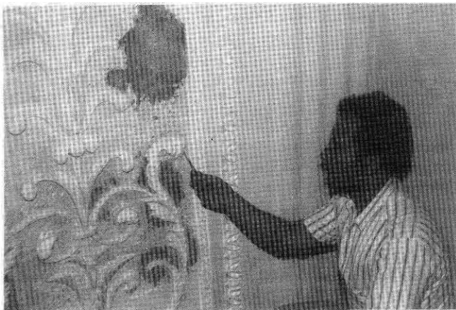
Erasmo Calderaro lavora agli stucchi
