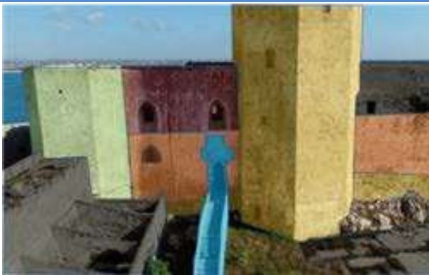
Fig. 5 - Lettura stratigrafica delle parti più antiche del complesso. La torre orientale forse araba o normanna (verde), la torre ottagonale e la muratura del XIII sec. (giallo), la cinta muraria medievale del XIV (arancio).
