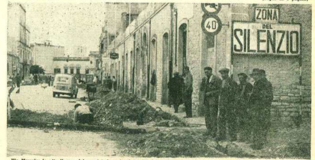
Via Marsala: in alto l'opera dei guastatori mentre i tecnici del nostro Comune stanno a guardare
