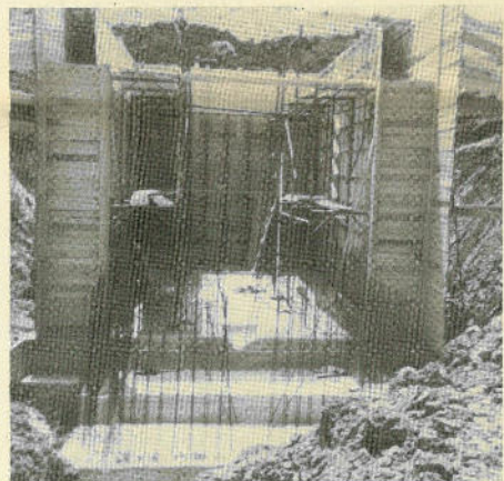
Un'opera in costruzione
