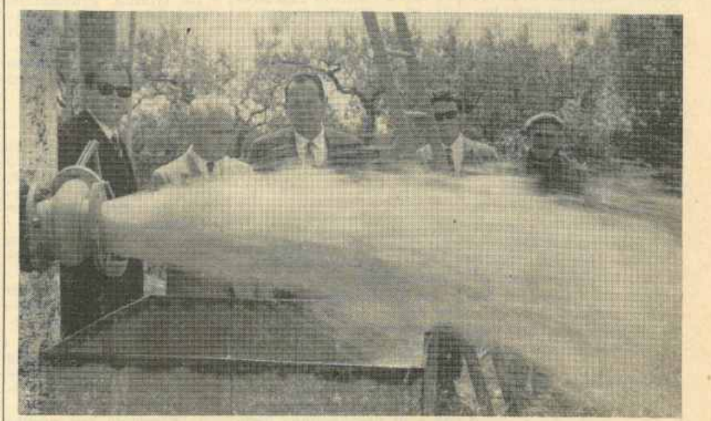
Sopra: Il potente getto di uno dei dieci pozzi di Bresciana, il TR4A che eroga 52 litri al secondo di acqua.
