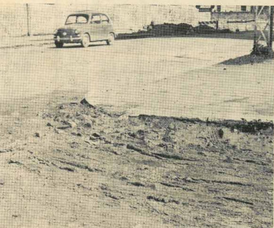
L'Ufficio Tecnico del Comune sta facendo riparare i marciapiedi di Piazza Vittorio Veneto con i fondi destinati alla riparazione dei danni alluvionali. Il fango dell'alluvione, invece, e i tombini otturati restano così come li ha lasciati l'alluvione e come chiaramente mostra la fotografia scattata in questi giorni all'altezza dell'ingresso principale della Caserma Giannettino
