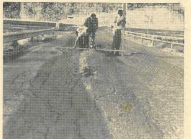
Ecco come si presentava la «scaffa» subito dopo l'incidente mortale con punte di profondità di oltre 25 cm.!
