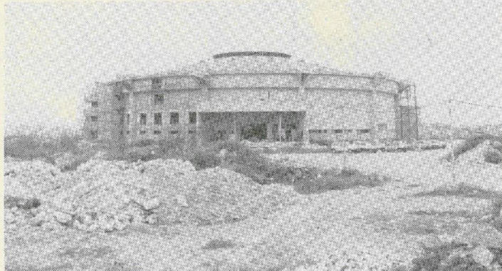
L'area del costruendo Palazzetto dello Sport (Foto G. Caraccia)
