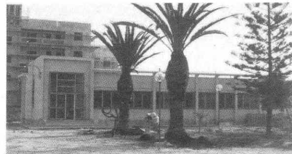
La nuova sede della Commissione Edilizia di Erice, in un'ala ristrutturata dell'ex officio industriale
