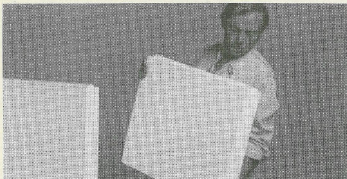
Fase di realizzazione di una tramezzatura con pannelli Gesblok
