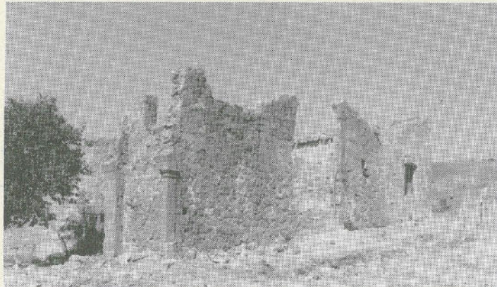
Un baglio risalente alla fine del secolo scorso in territorio di Calatafimi. Fu costruito utilizzando la pietra di gesso locale. Anche le strutture sulle quali poggiavano le mensole del balcone (foto in basso) erano in pietra di gesso
