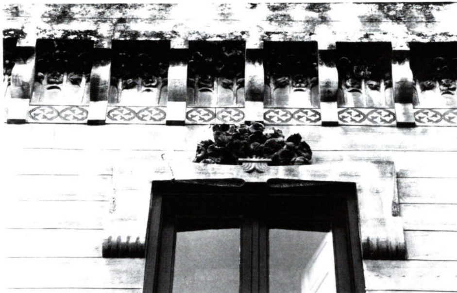
CASA AGUECI - Coronamento (particolare)
