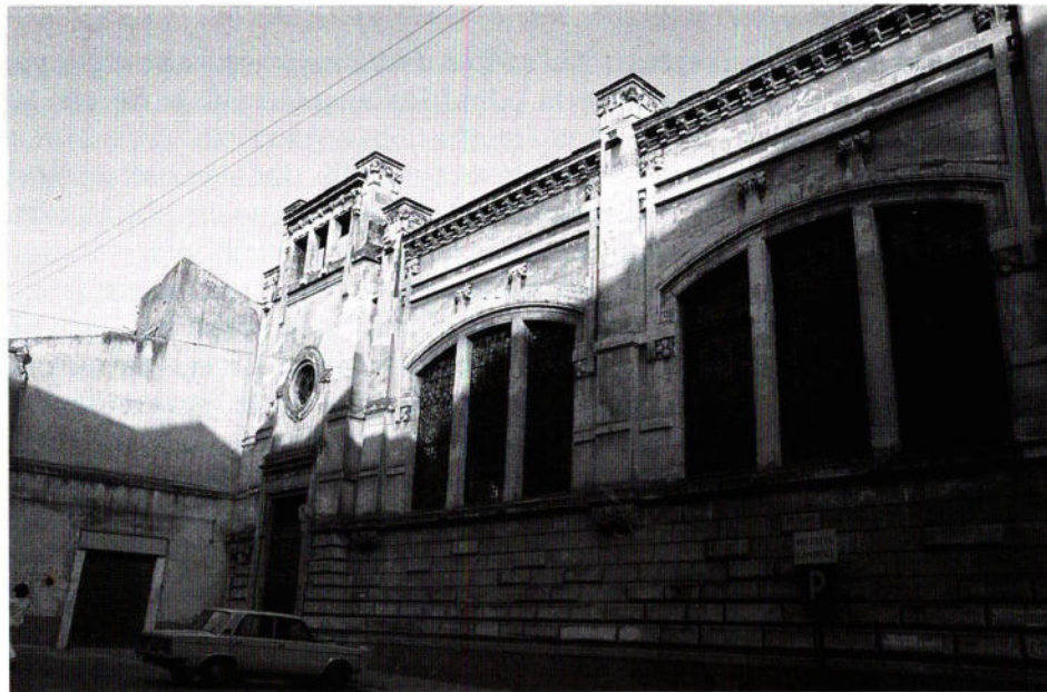
CENTRALE ELETTRICA - Caltagirone (foto di M.A. Spadaro)
