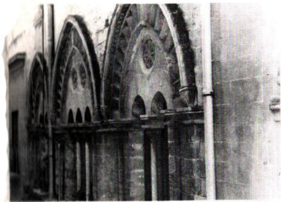
Resti del palazzo trecentesco che occupava l'isolato dello Steri
