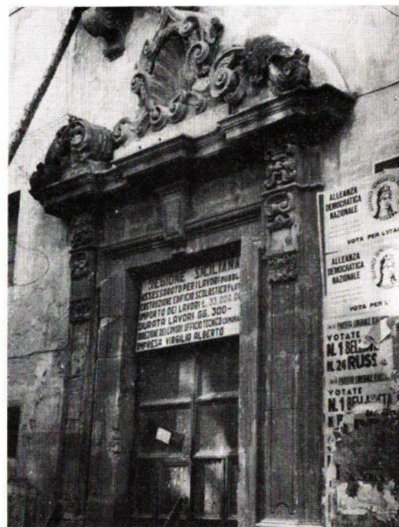
Il portale del convento di S. Giovanni ancora in sito. A seguito della demolizione dell'edificio, esso venne rimontato in via Orfane su iniziativa dell'architetto Marrone
