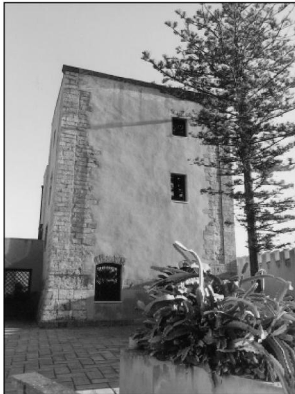
La Torre dopo il restauro - lato sud-ovest
