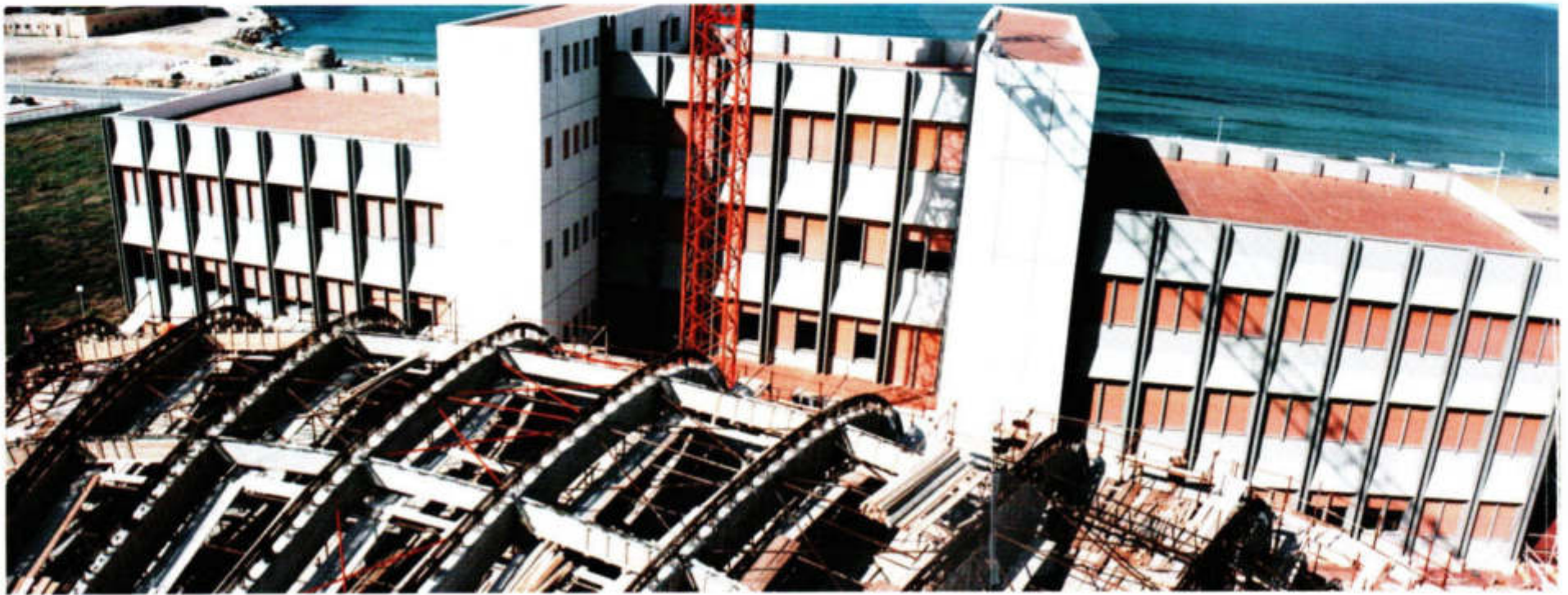
Veduta del corpo'aule dalla terrazza dell'edificio palcoscenico. In primo piano, le travi principali e secondarie di copertura dell'auditorium nella fase che ha preceduto la collocazione della lamiera grecata.
