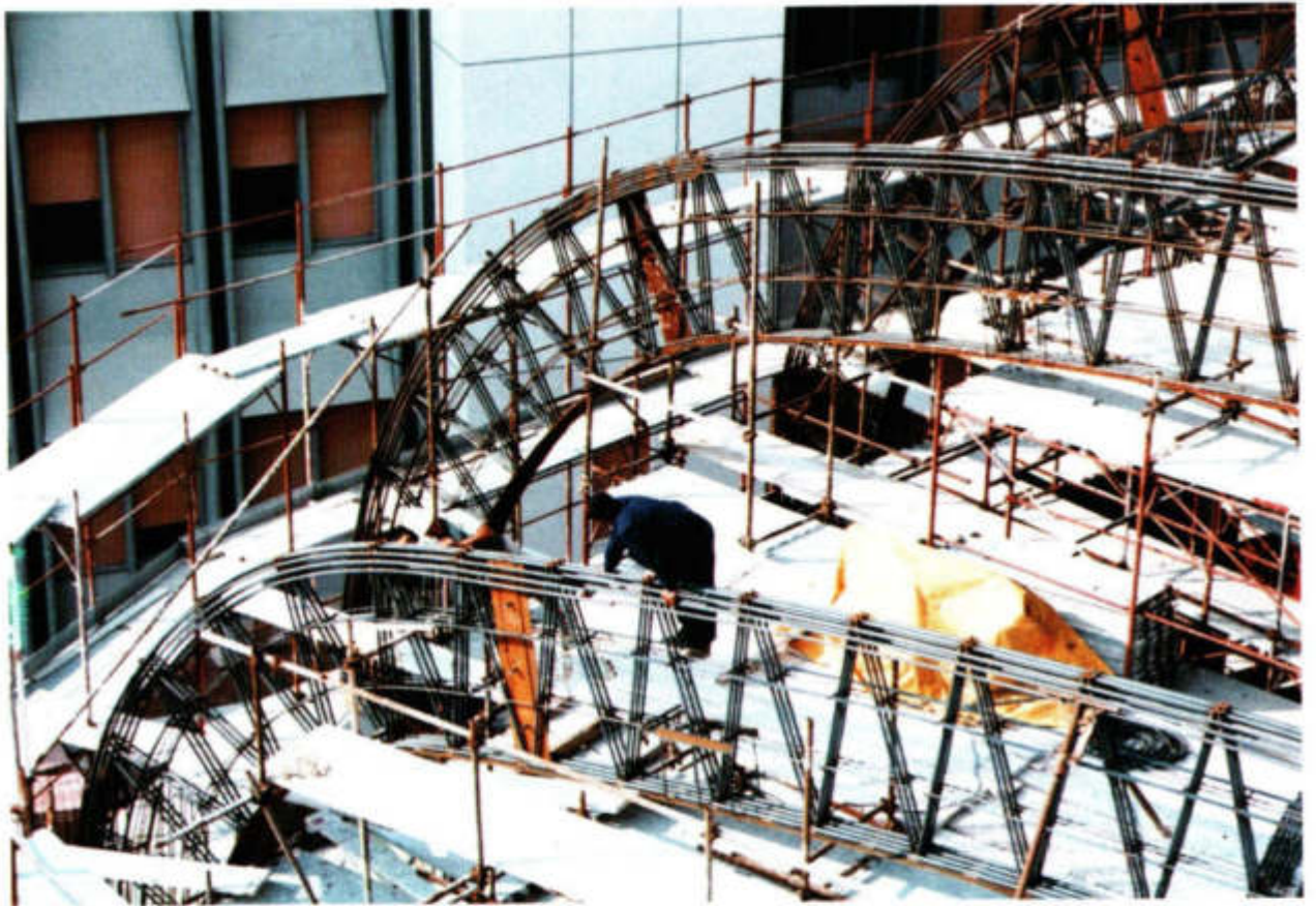
Un particolare delle travi principali alte m. 1,60. Come si nota, sono divise in tre parti. La parte inferiore di cm. 50 e quella superiore di cm. 50 sono in vista all'interno ed all'esterno della copertura. Nella parte centrale (cm. 60) sono contenute tutte le travi secondarie e di contraventatura nonché tutti i cavi elettrici e dei vari servizi (antincendio, antenne, ecc.).
