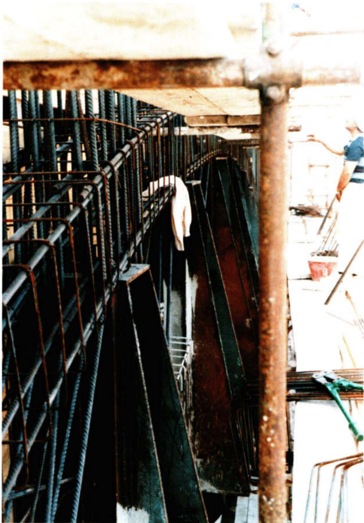
Trave di boccascena. Si notino gli alloggiamenti metallici per l'inserimento delle testate delle travi di copertura dell'auditorium.
