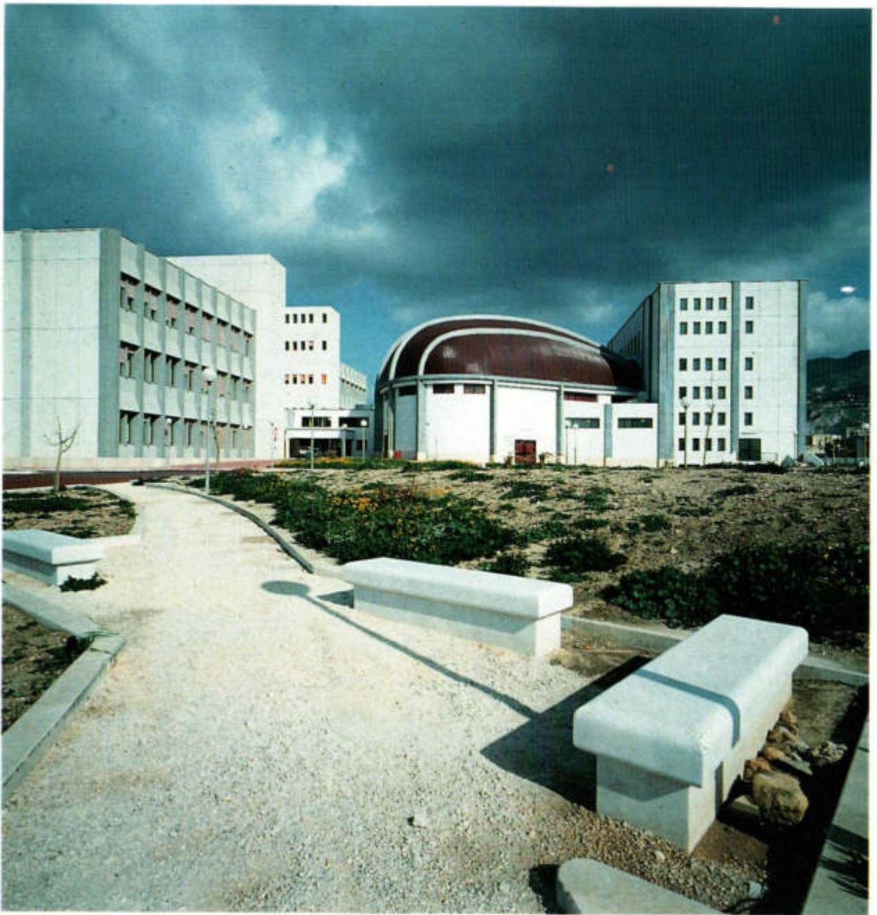
Lato ovest della costruzione.
