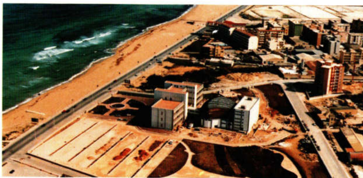
Veduta aerea del complesso durante i lavori.
