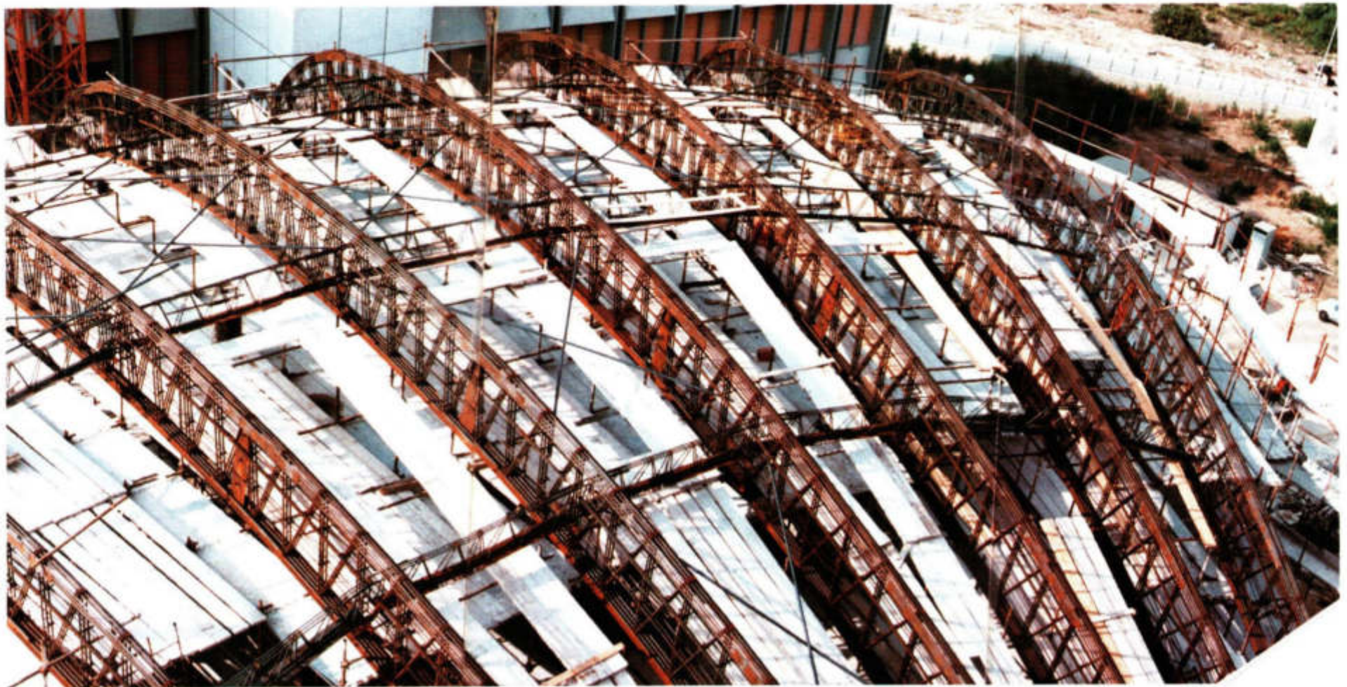
Armatura a ferri saldati delle travi di copertura dell'auditorium.
