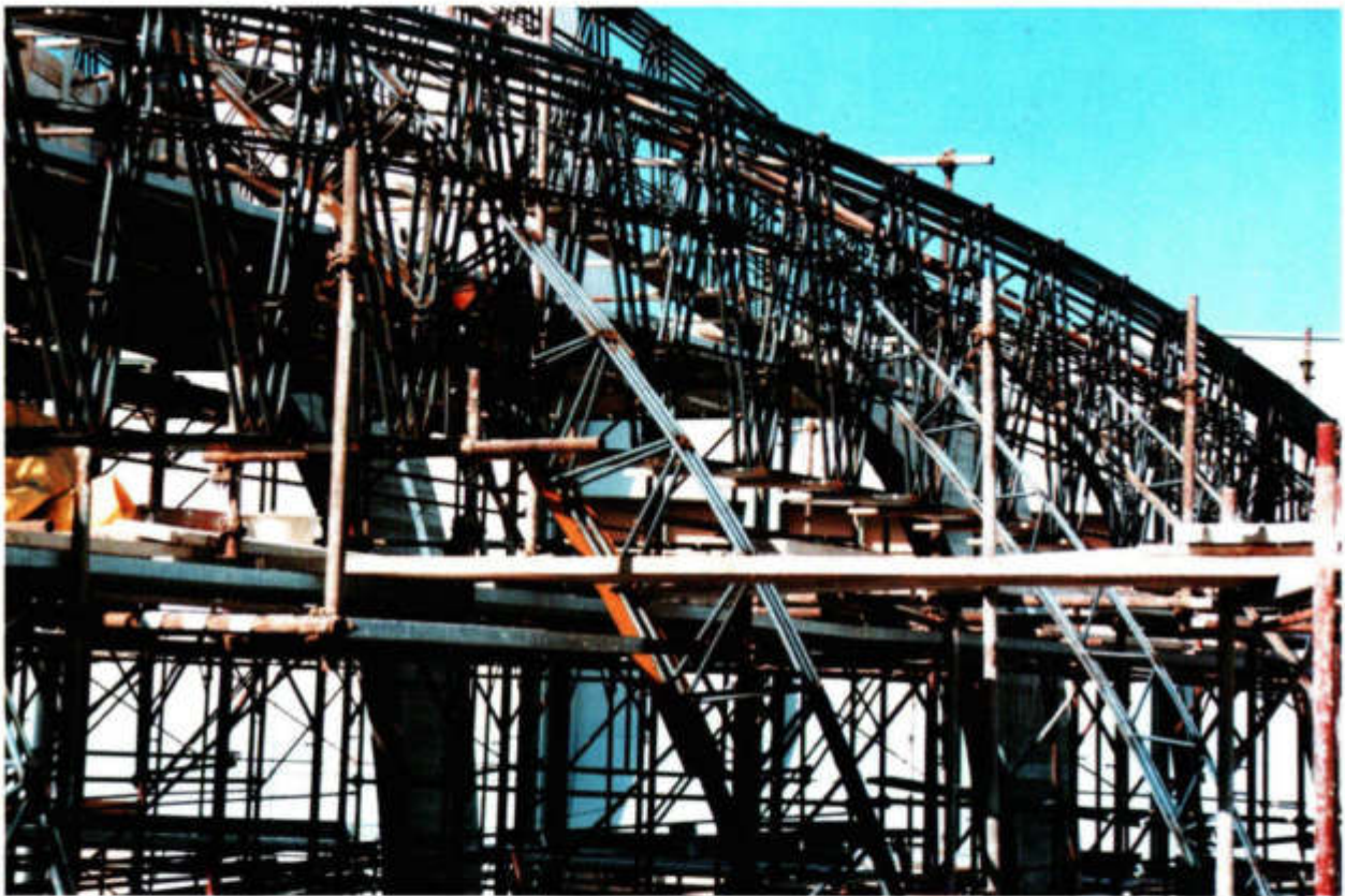
Particolare delle armature delle travi principali e secondarie dell'angolo nord-est dell'auditorium. Si rammenta che ogni tondino di ferro delle armature è derivato da un apposito calcolo di stabilità. I calcoli sono agli atti del Genio Civile di Trapani.
