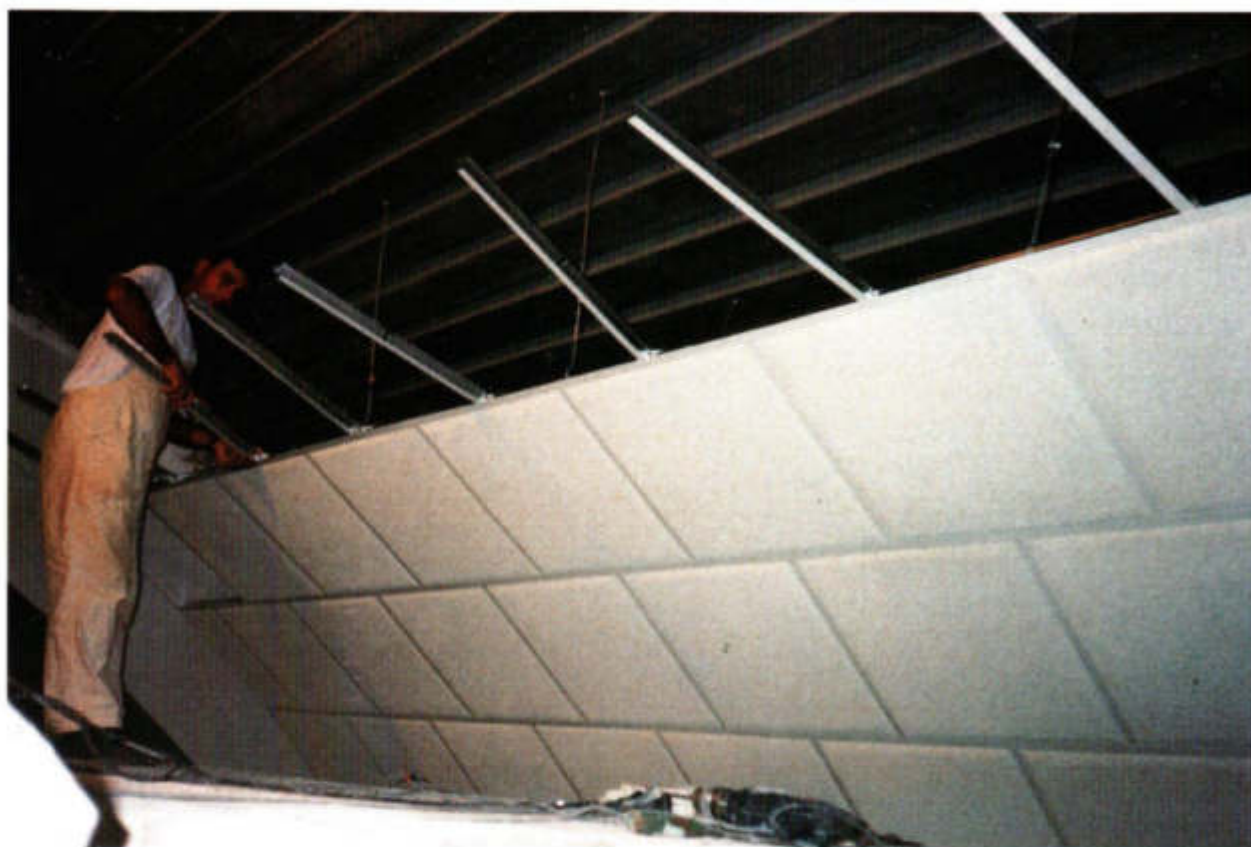
Collocazione dei pannelli fonoassorbenti per il soffitto dell'auditorium.
