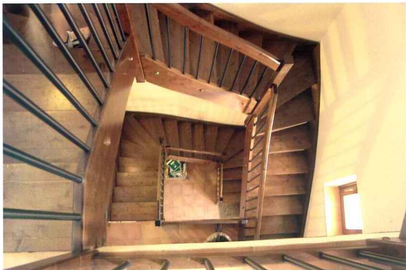
Scala della torre (part.)
