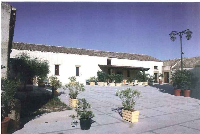
Corte interna (lato sinistro)
