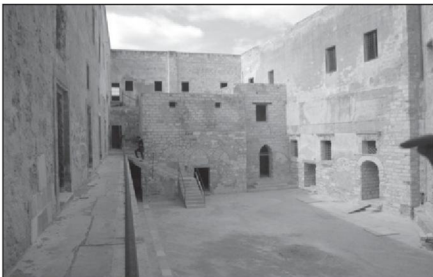
Il Cortile dopo il restauro (2013)
