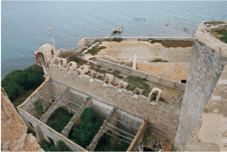
garitta e nove finestre (stato attuale)
