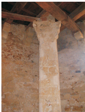
enormi pilastri che sostengono i solai.
