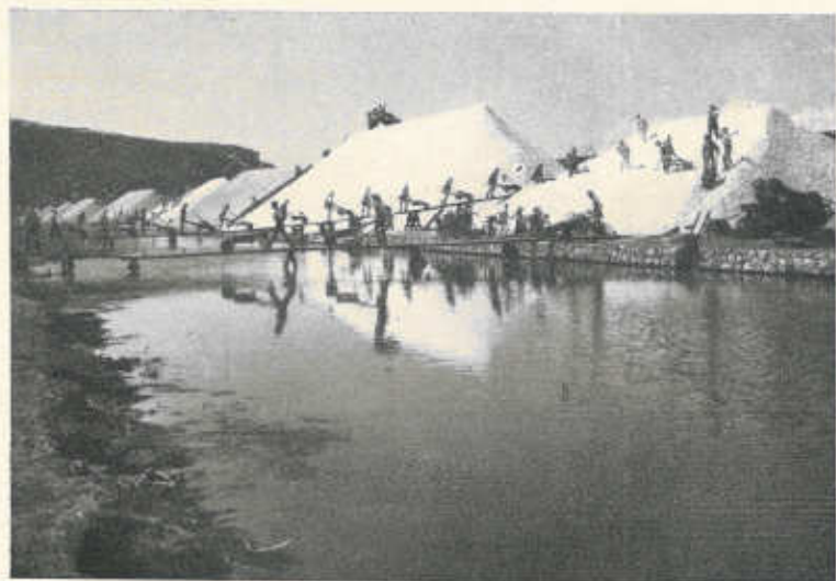
28 — R. Salina di Cagliari - Accumulamento con carriole.
