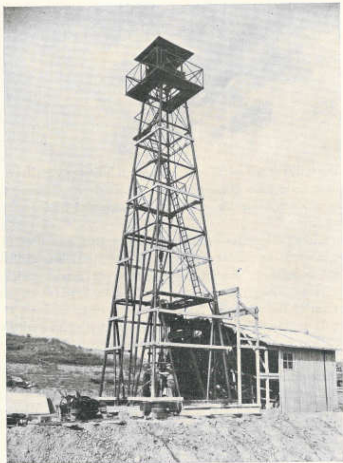
43 — Ponte Ginori (Pisa) - Torre di trivellazione italiana.
