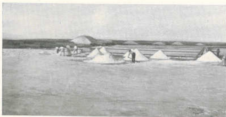
59 — Le saline di Augusta - Rottura della crosta salina e formazione di cumuli conici.
