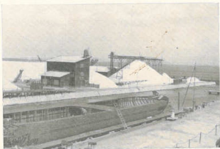
66 — La salina di Santa Gilla presso Cagliari - Impianti per la raffinazione del sale producenti il tipo speciale per la salagione del pesce e per usi elettrolitici.
