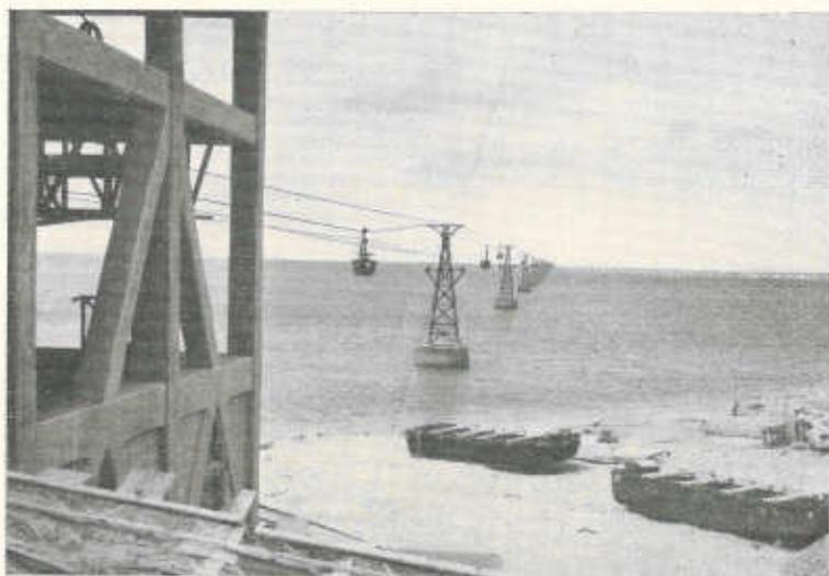
36 — Salina di Dante (Hafun) in Somalia - Stazione d'angolo della teleferica a El Gafi.
