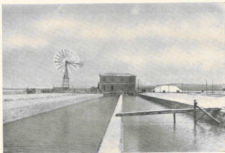
80 — Salina di Dante (Hafun) in Somalia - Idrovora principale e aeromotore.
