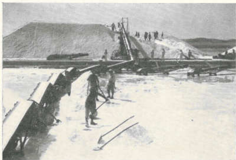
82 — Salina di Dante (Hafun) in Somalia - I nastri trasportatori all'uscita del sale.
