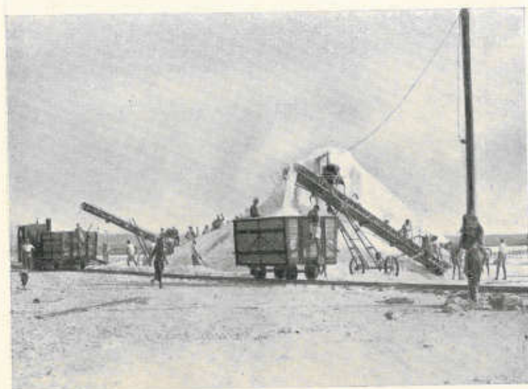
78 — Salina di Assab - Caricamento meccanico dei carrelli ferroviari.
