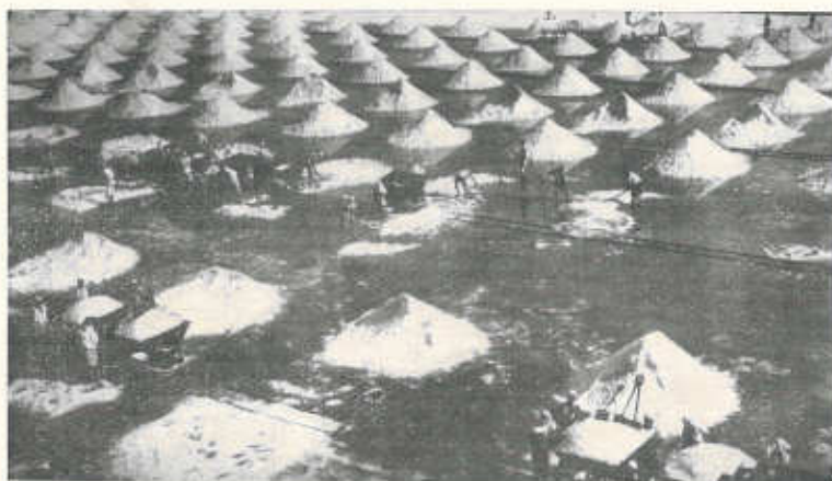
67 — La salina di Tripoli (El Mellaha) - Cumuletti conici nelle salanti e trasporto del sale sulle aie a mezzo decauville.
