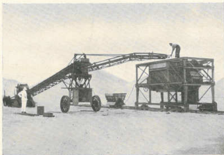
84.— Salina di Dante (Hafun) in Somalia - Dolberg con elevatori a nastro.
