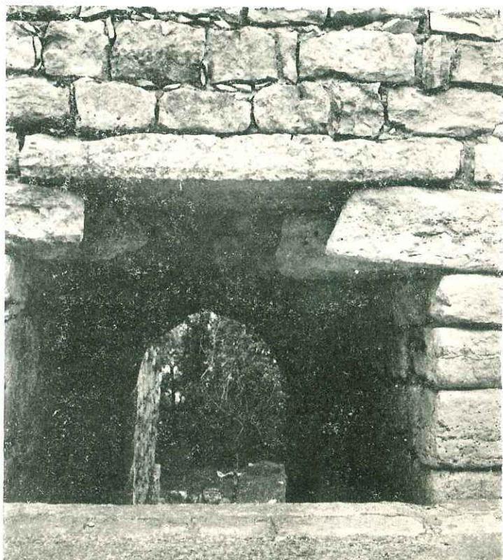
Fig. 10 - (sotto) - Postierla ad architrave rettilineo (parzialmente interrata)
