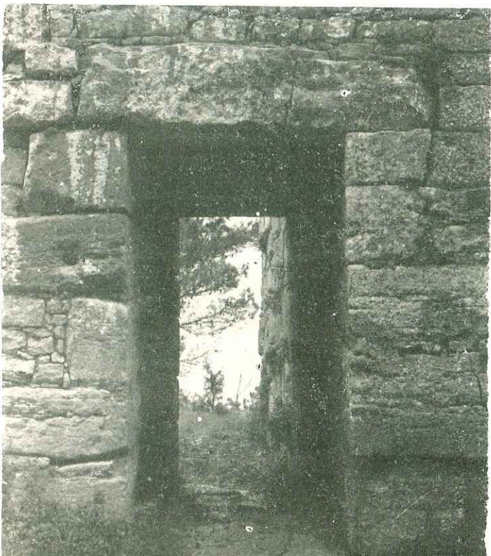
Fig. 9 - (sotto) Postierla ad architrave rettilineo presso Porta Spada
