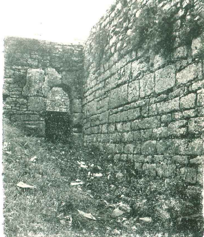
Fig. 8 - (sopra) - Particolare delle mura con una postierla a pseudo arco presso Porta Spada
