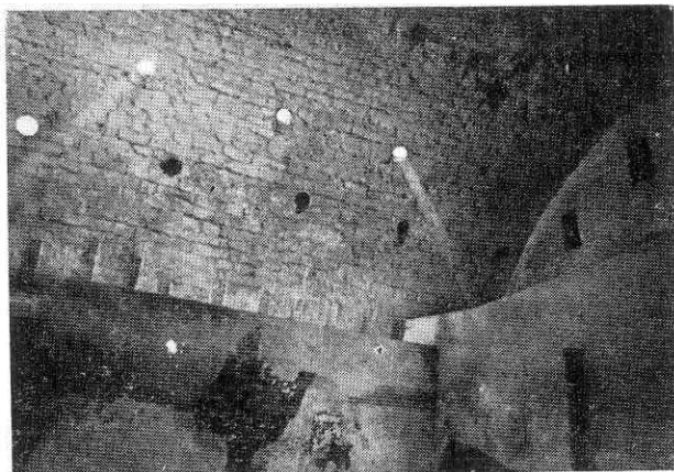
Fig. 10 - Veduta della volta normanna con fori per illuminazione e aereazione
