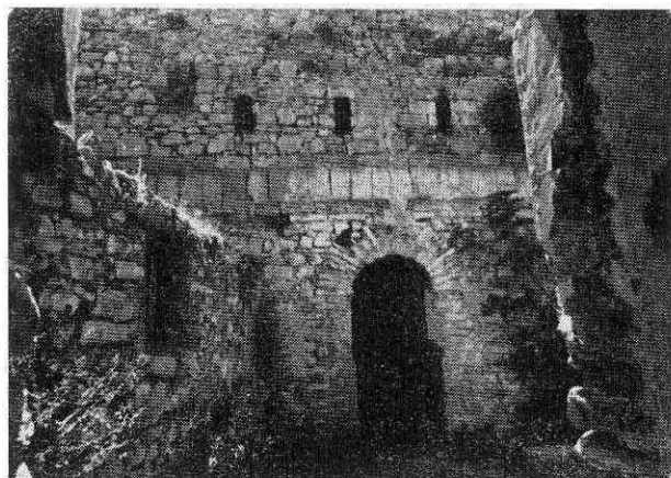
Fig. 5 - Porta d'ingresso, fascia in tufo e muro soprastante
