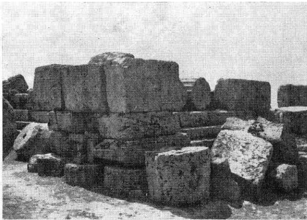
Particolare del contrafforte nord-ovest in parte abbattuto
