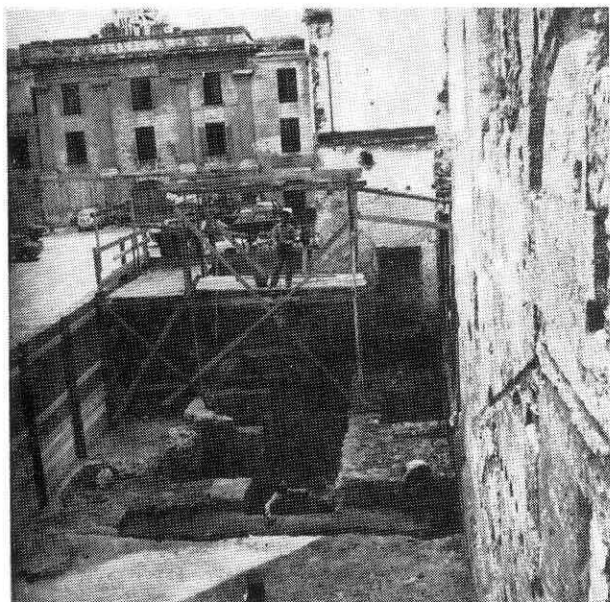
STERI: il Saggio V, nel corso dei lavori di scavo, visto da Ovest
