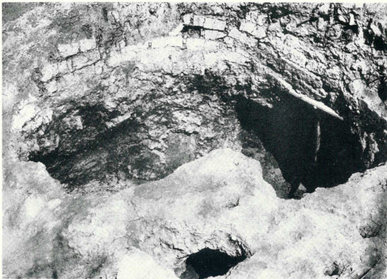
Muro perimetrale in mattoni crudi e piano forato
