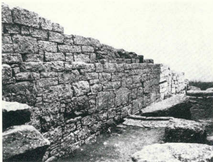
FIG. 12 - Il muro occidentale dell'agorà.
