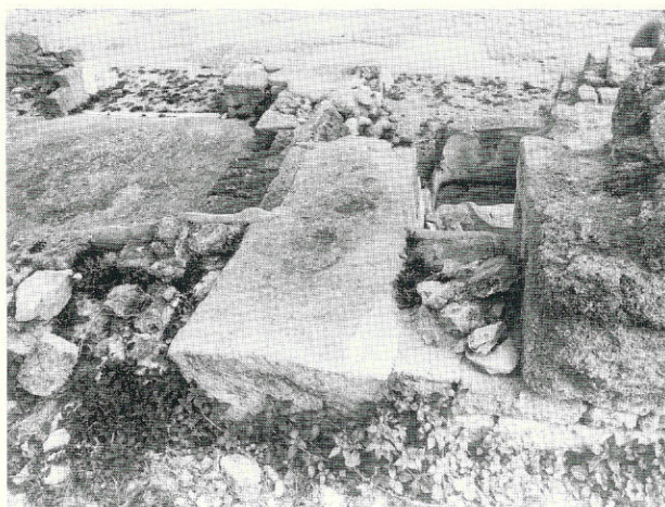
FIG. 5 - Particolare del muro M 4 (da Ovest).
