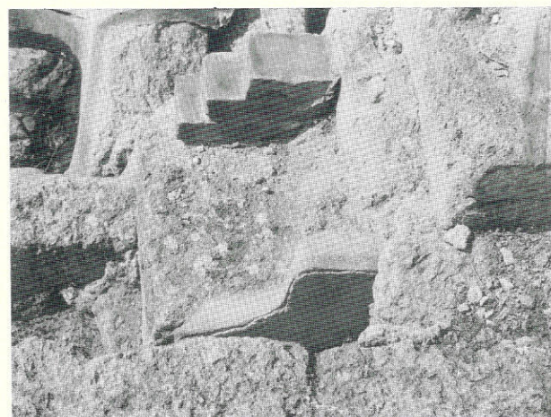
FIG. 25 - Particolare dell'intonaco della faccia N del muro M 4 (dall'alto).
