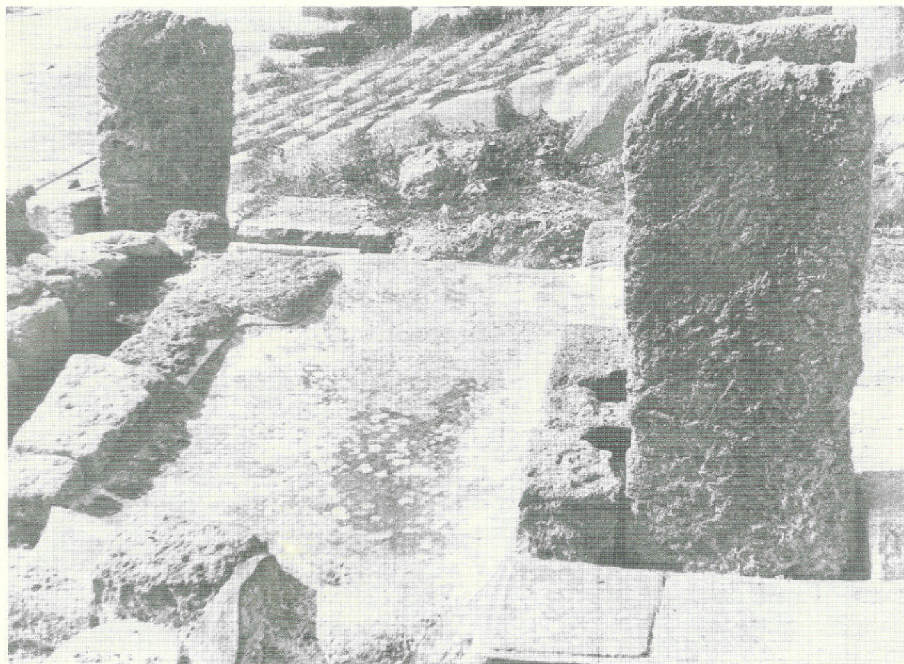
FIG. 9 - Piano inclinato (da Nord).
