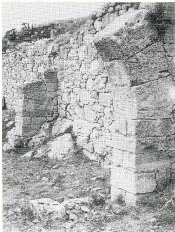
FIG. 43 - Vano n , piedritti degli archi (da Nord).
