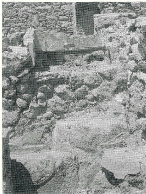
FIG. 31 - Vano h , nicchia e piattaforma semicircolare (da Est).
