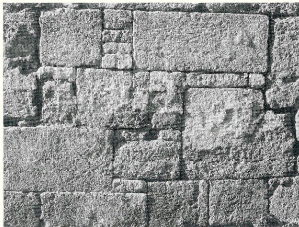
FIG. 45 - Edificio A, muro M 1.
