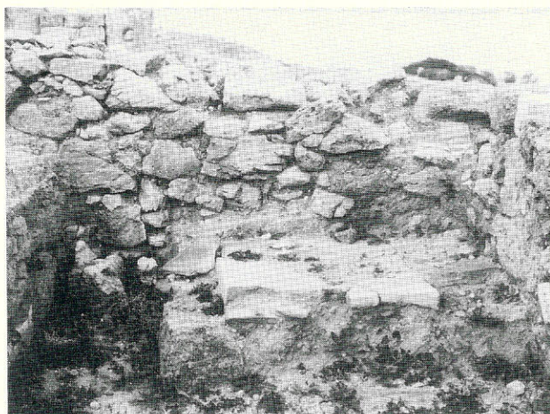
FIG. 38 - Vano g , ripiano di mattoni (da Sud).
