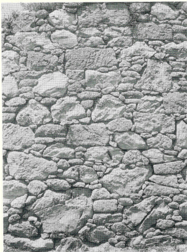
FIG. 46 - Edificio B, muro M 56.
