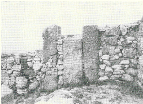
FIG. 29 - Vano i , muro M 48 (da Nord).
