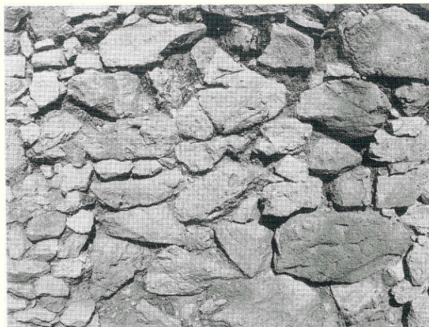
FIG. 47 - Edificio B, muro M 46.
