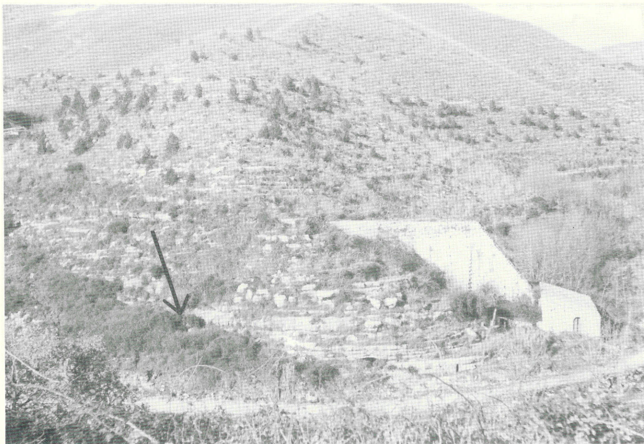
FIG. 2 - Alla sinistra del Mulino l'ingresso dell'ipogeo.
