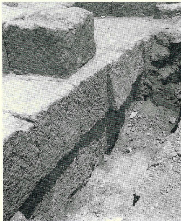
FIG. 5 - Marsala. Particolare delle fortificazioni puniche del lato SO (proprietà Rallo e Aguanno).
