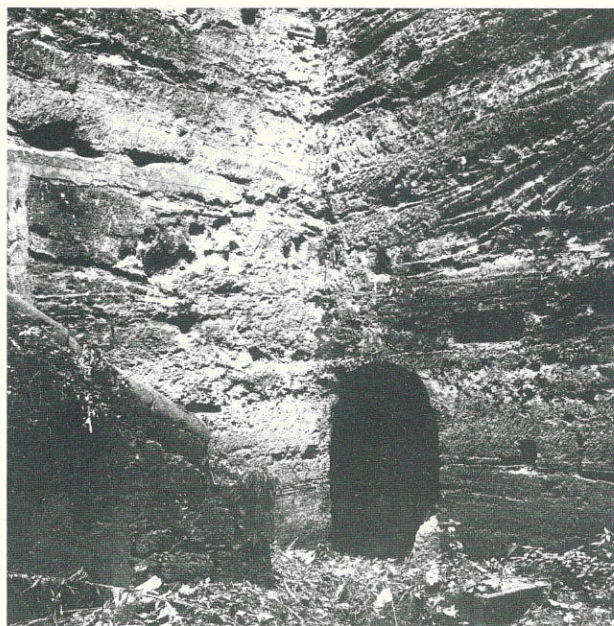
Fig. 3 - Palermo, Piazza Edison. L'ingresso della galleria dal fondo del pozzo.
