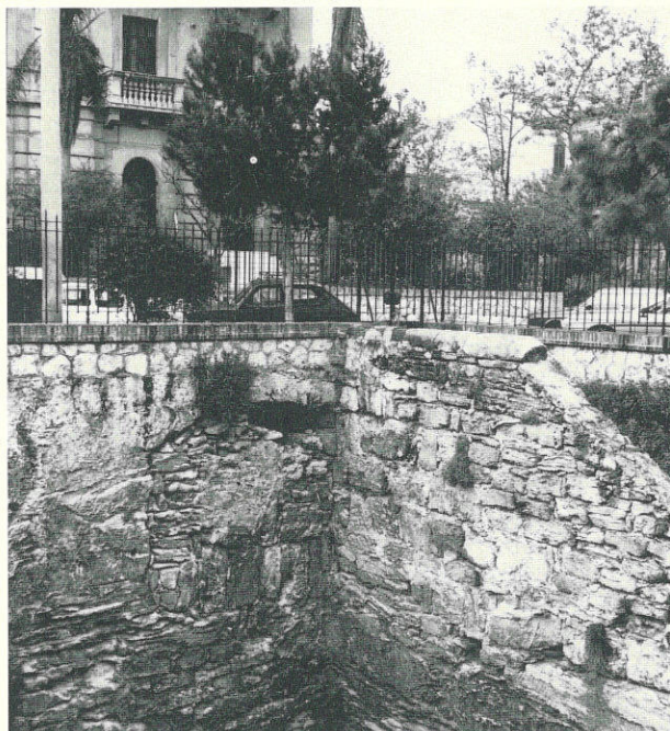
Fig. 6 - Palermo, Piazza Edison. L'ingresso del pozzo e la preesistente cavità ipogeica.
