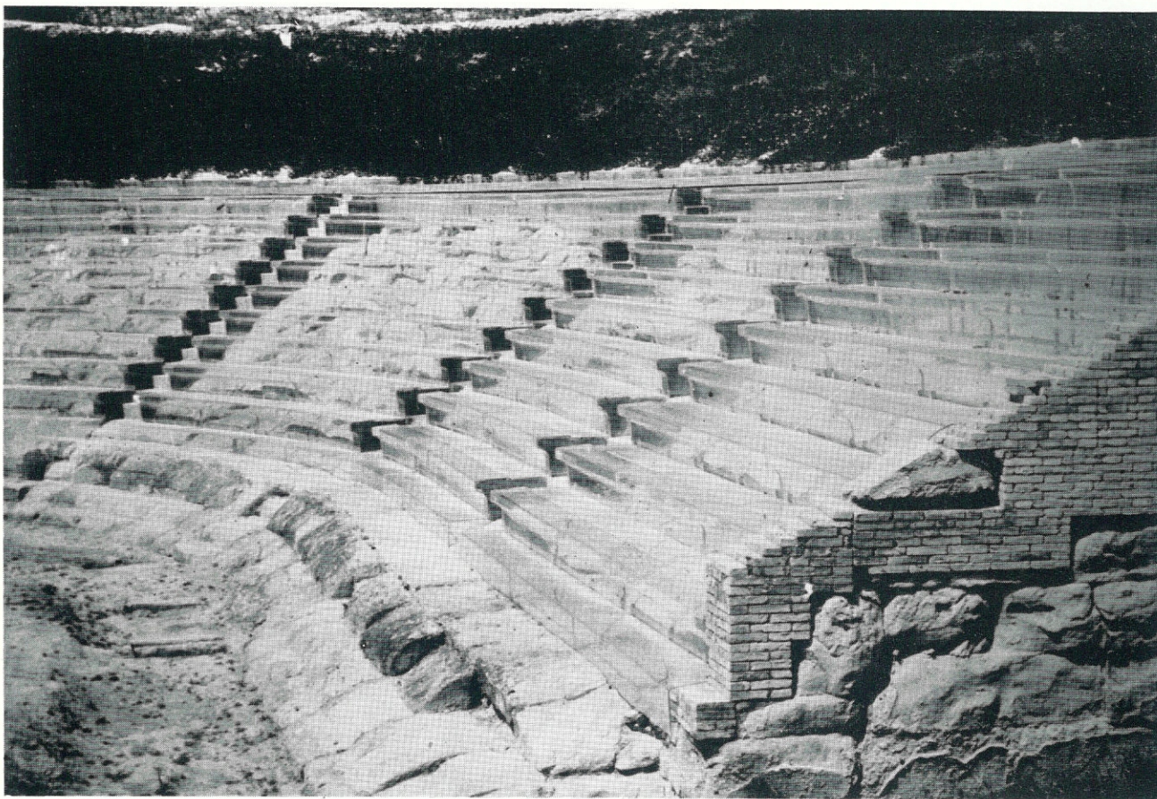
FIG. 6. ERACLEA MINOA - Il teatro ellenistico con le originali opere di protezione in perspex ideate dal Minissi.
