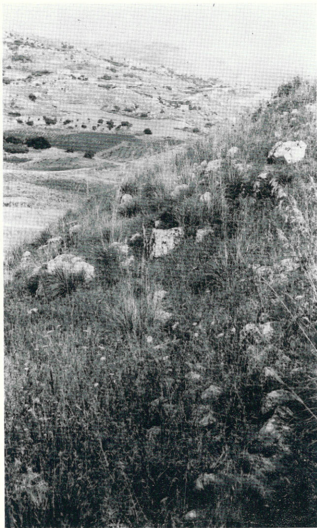
FIG. 40. Castello di Palma. Resti del muro di cinta tra il folto della vegetazione.
