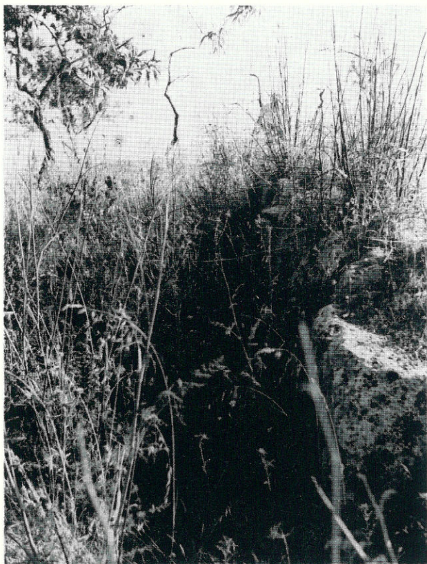
FIG. 48. Contrada Ragusetta. Il muro di fortificazione della fattoria.
