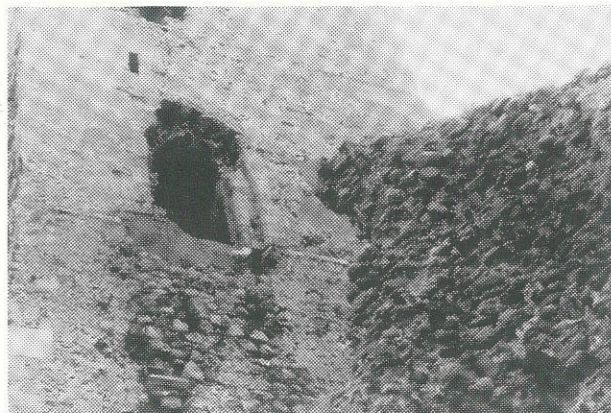
Fig. 18 - Prospetto N: rampa scalare e porta d'ingresso.
