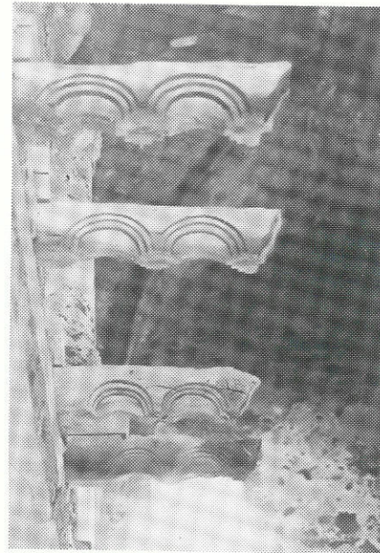
Fig. 39 - Particolare delle mensole.
