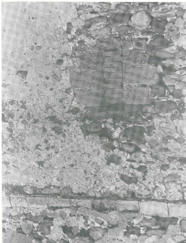
Fig. 14 - La feritoia tompagnata al piano terreno del prospetto N.
