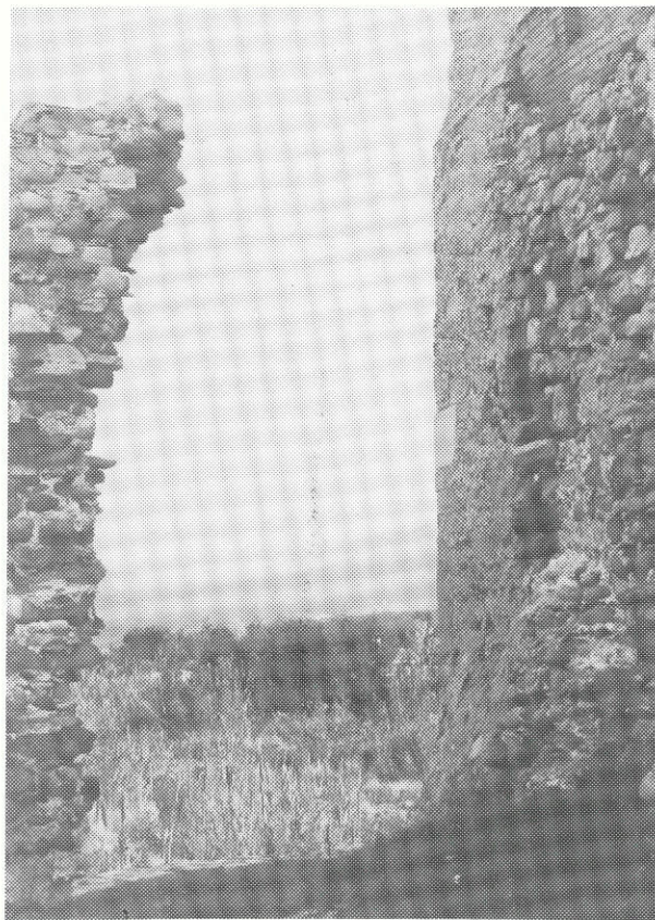
Fig. 17 - Prospetto N: rampa scalare e porta d'ingresso.
