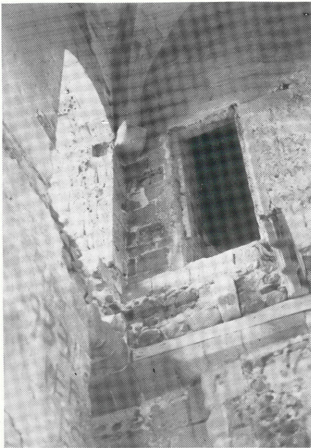
Fig. 52 - La porta d'accesso alla scala che conduce alla terrazza.
