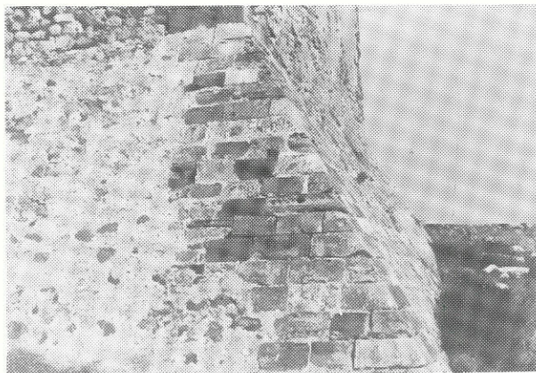
Fig. 10 - Particolare della scarpa.
