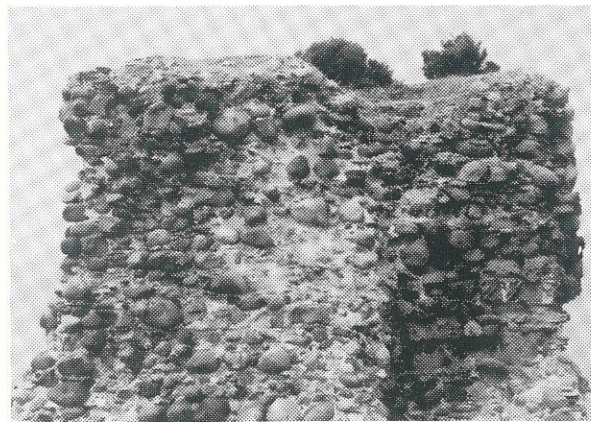
Fig. 58 - Esterno del locale a cupola. Sulla sinistra il vano dell'antica scala a chiocciola.
