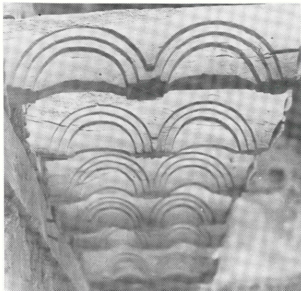
Fig. 38 - Le mensole in origine reggenti le travi del soffitto fra primo e secondo piano.
