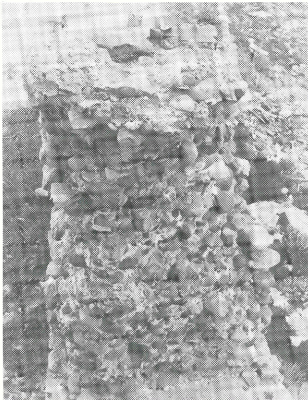
Fig. 8 - Rovine del baglio di Roccella, particolare delle strutture murarie.
