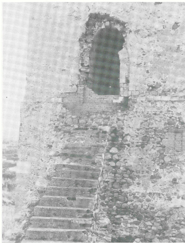
Fig. 15 - Prospetto N: la rampa scalare e la porta d'ingresso.
