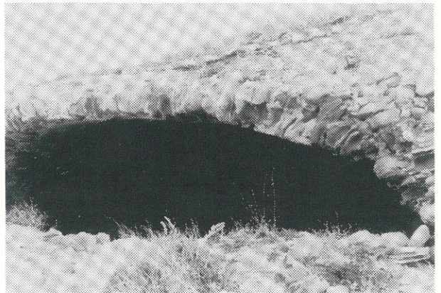
Fig. 54 - Particolare di una delle volte a botte.
