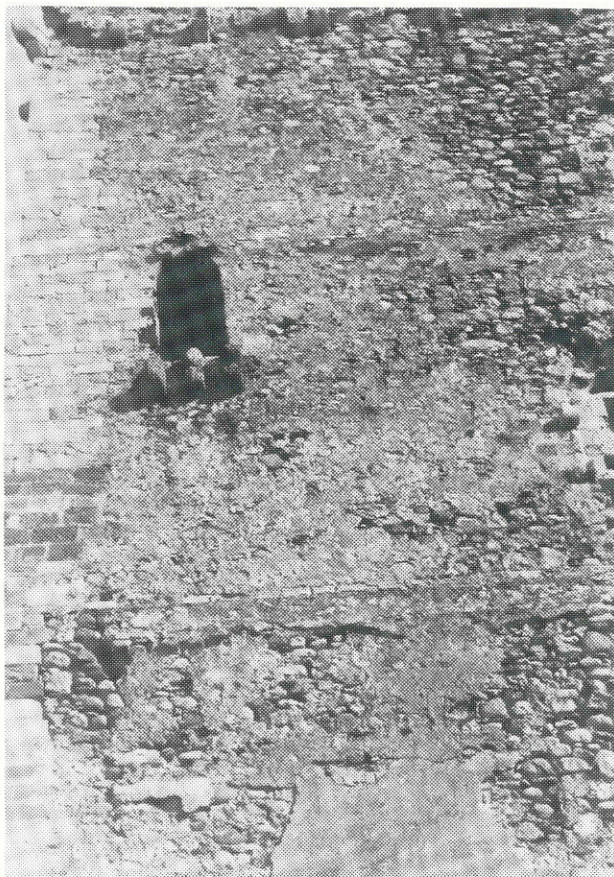
Fig. 32 - Prospetto O: l'ipotetica latrina.
