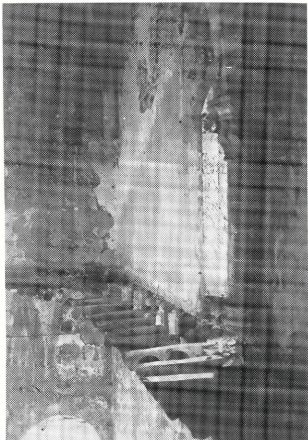
Fig. 49 - Mensola di imposta della nervatura sull'angolo SO.
