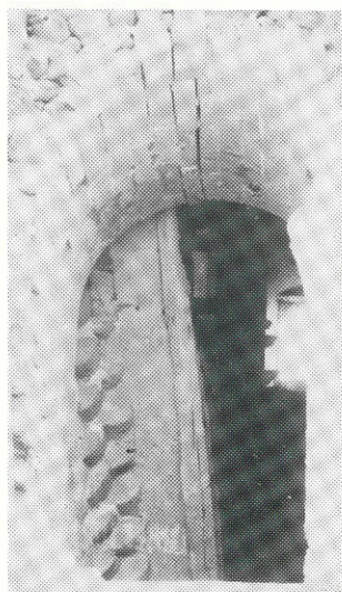
Fig. 42 - I mensoloni che sostengono la prima rampa aggettante della scala di collegamento fra primo e secondo piano.
